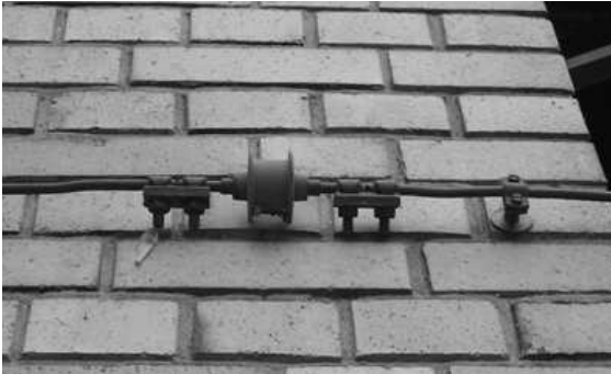
그림 3. 방전갯을 이용한 피뢰등전위본딩 사례
