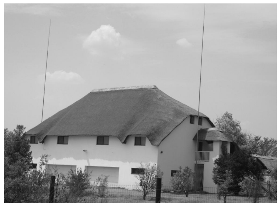
그림 3. 구조물과 분리된 외부 LPS 시공 사례
