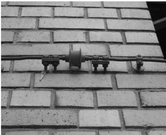
그림 5. 절연방전갭의 설치 사례
