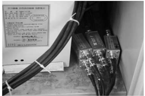
그림 5. 통신시스템에 SPD를 적용한 사례
